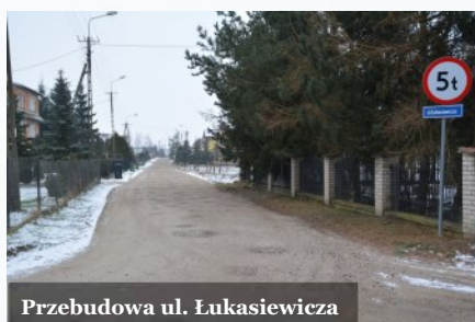
Przebudowa ul. Łukasiewicza
