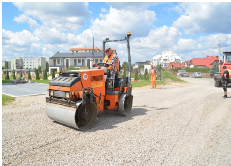
Remont przeszy ul. Św. Krzysztofa i fragment ul. Rzeczkowskiej. Na drogach osiedlowych ustawiono znaki A5.
