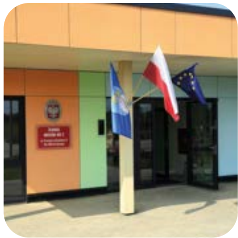
BUDOWA ŻŁOBKA MIEJSKIEGO NR 2 15,9 MLN ZŁ
