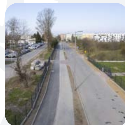
BUDOWA ALTERNATYWNYCH DOJAZDÓW DO SZPITALA 11 MLN ZŁ
