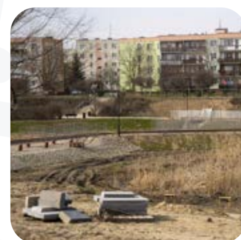
BUDOWA ZBIORNIKA RETENCYJNEGO NA JEZIORKU
