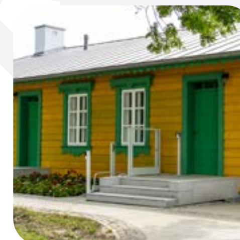
REKNOSTRUKCJA BUDYNKU KOLEI NADWIŚLAŃSKIEJ 3,2 MLN ZŁ
