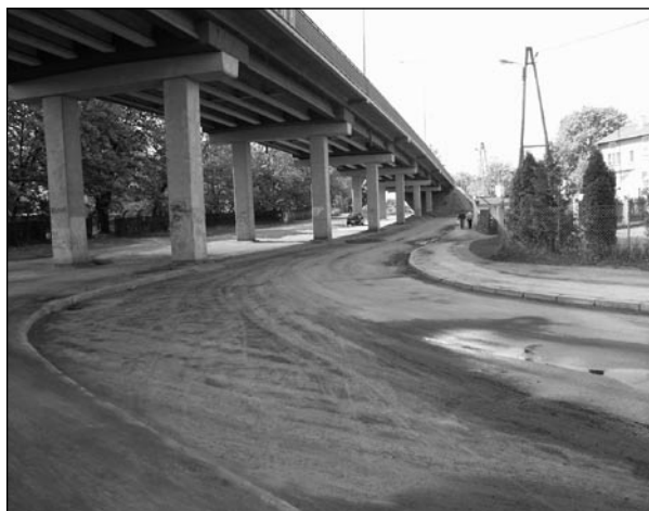
5 dni po czyszczeniu drogi wody opadowe znowu naniósł piasek i ziemię
