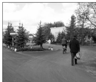
Wyremontowany wjazd na bazarek przy ul. Sienkiewicza
