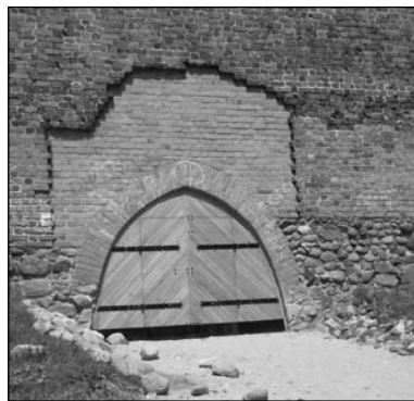
Nowa brama od strony południowej
