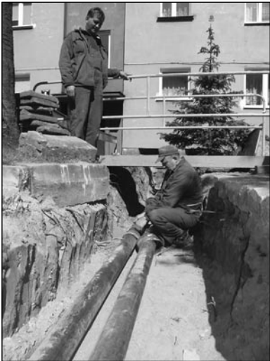
W trakcie robót przy ul. Wyzwolenia
