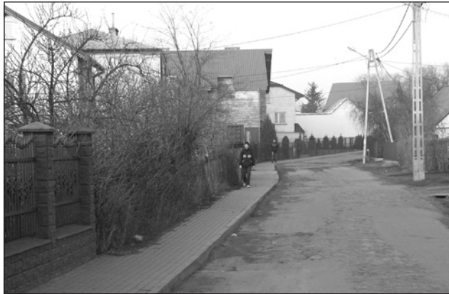
Ul. Zagumienna potrzebuje infrastruktury podziemnej, a dopiero na końcu położenia asfaltowej nawierzchni. Na razie jest tam jedynie nowy chodnik z kostki brukowej
