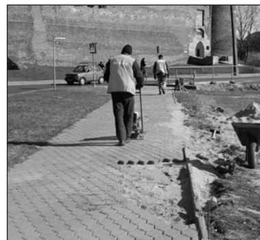
Prace na ul. Parkowej
