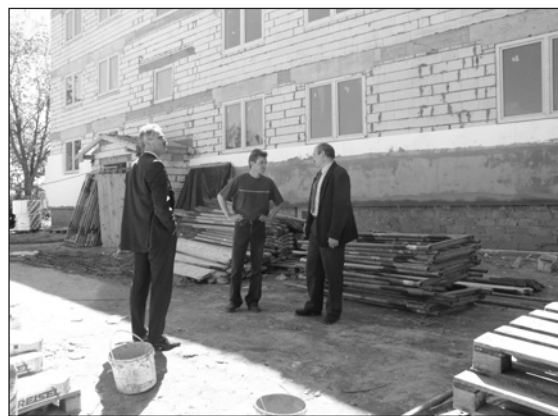
W. Wardziński (z lewej) i R. Szymanik kierownik Wydziału Inwestycji Urzędu Miasta (z prawej) sprawdzają postępy na budowie przy Komunalnej
