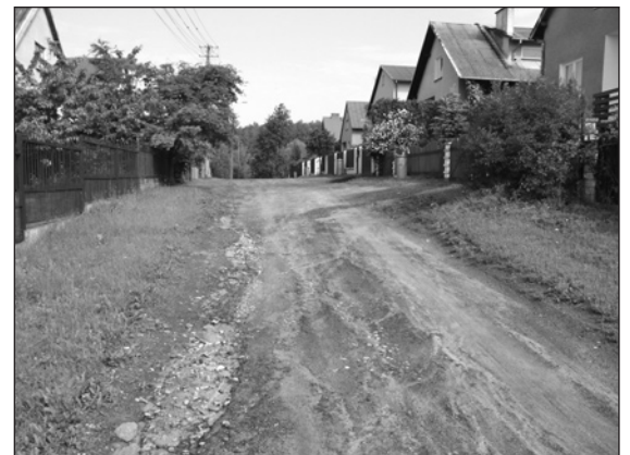
Kuny — jedna z ulic objętych projektem budowy kanalizacji, dróg i chodników
