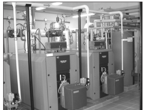
... i po remoncie
