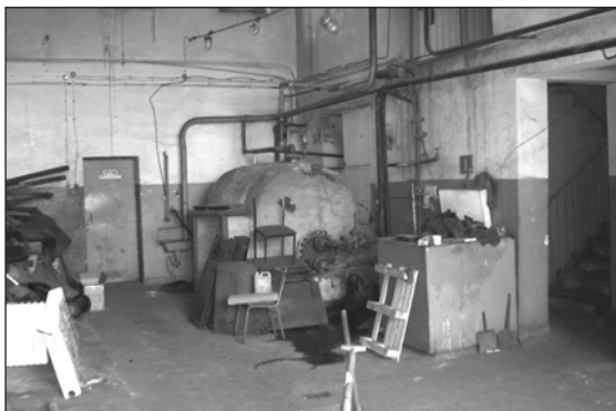
Kotłownia ZKM przed remontem...
