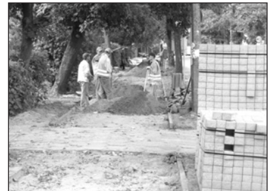
Budowa chodnika na Sienkiewicza
