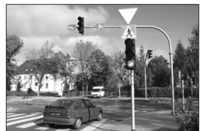
Sygnalizatory są widoczne z dużej odległości
