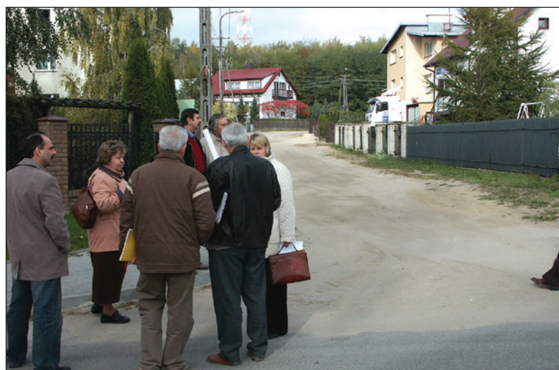
W przekazaniu terenu budowy oprócz inwestora i wykonawcy uczestniczą przedstawiciele służb miejskich
