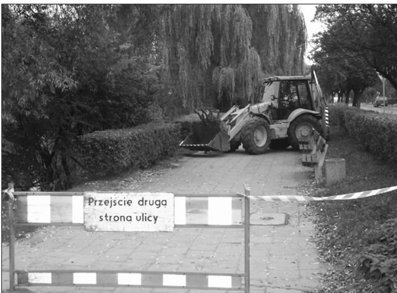
Budowa oświetlenia bulwaru wzdłuż ulicy Gostkowskiej to jedna z wielu inwestycji Lokalnego Programu Rewitalizacji
