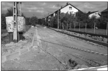
Trwają prace na Działkowej
