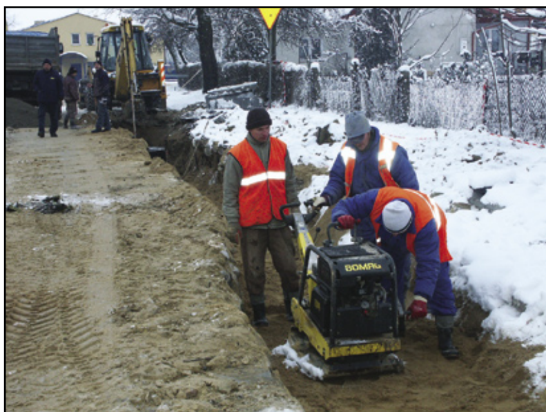
Prace na ul. Starowiejskiej trwały jeszcze w grudniu
