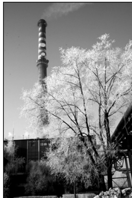
Żałoga PEC-u niektóre prace musiała wykonywać przy 30-stopniowym mrozie
