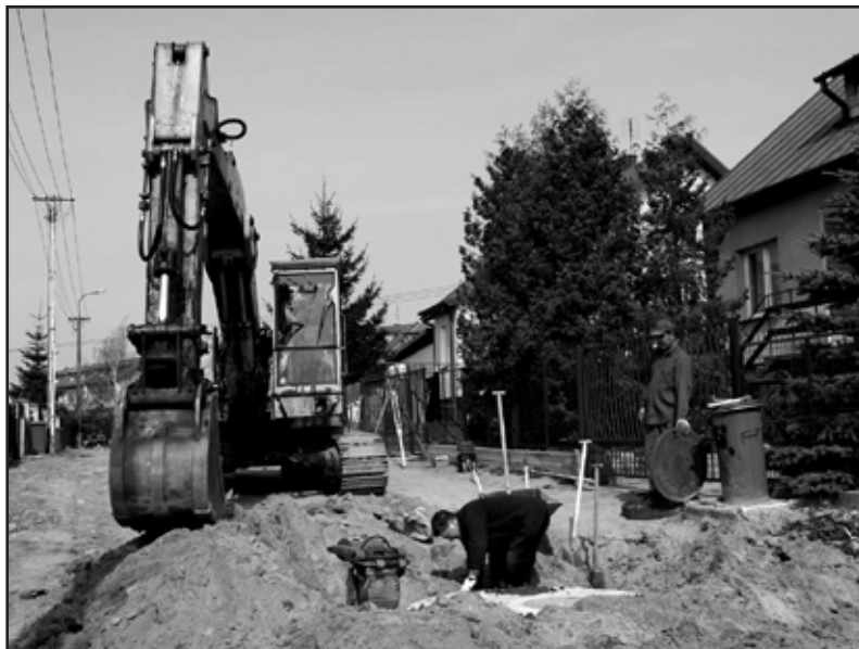
Prace na ulicy Zelwerowicza
