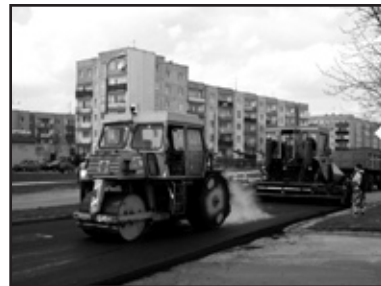
Budowa nakładki na Powst. Wielkopolskich
