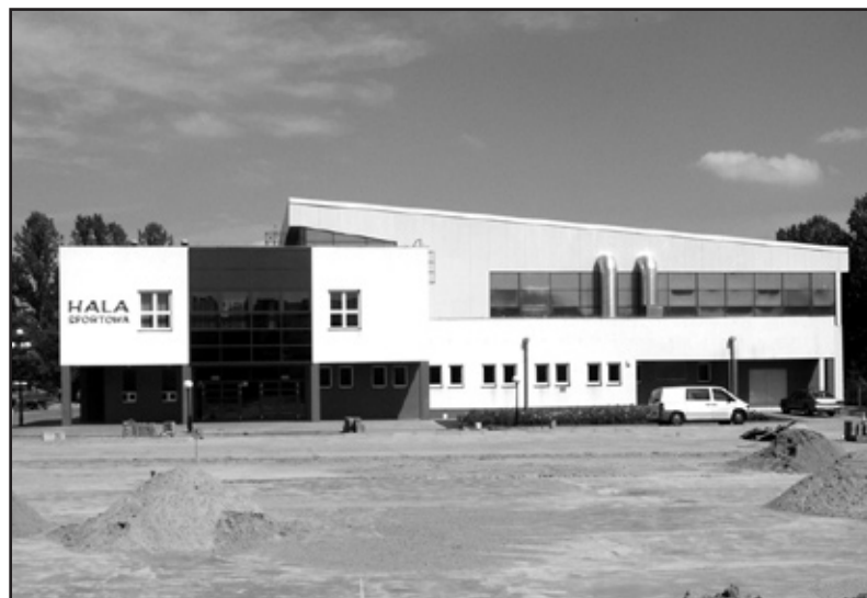
Parking przed halą podczas budowy
