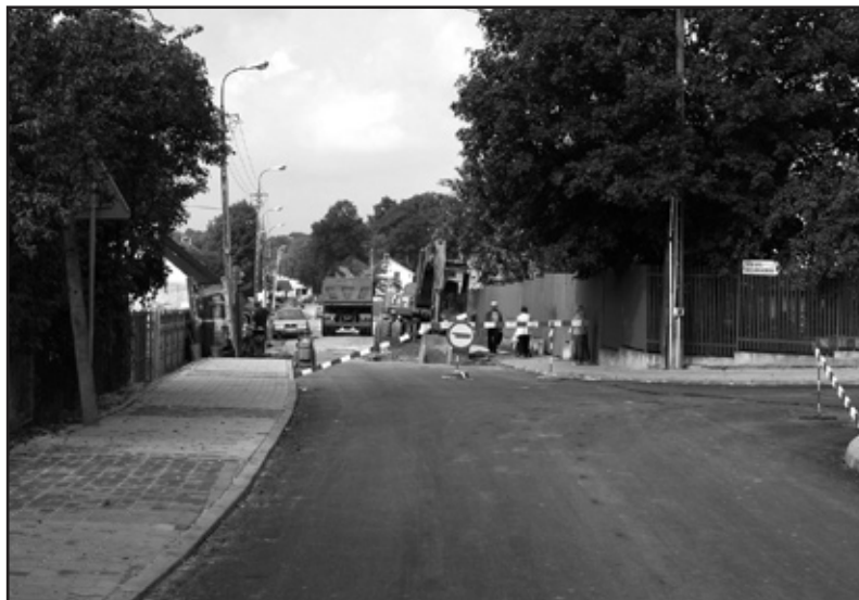
Rozpoczęły się prace na ul. Rzeczowskiej
