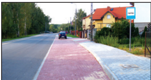
Nowa ul. Różyckiego
