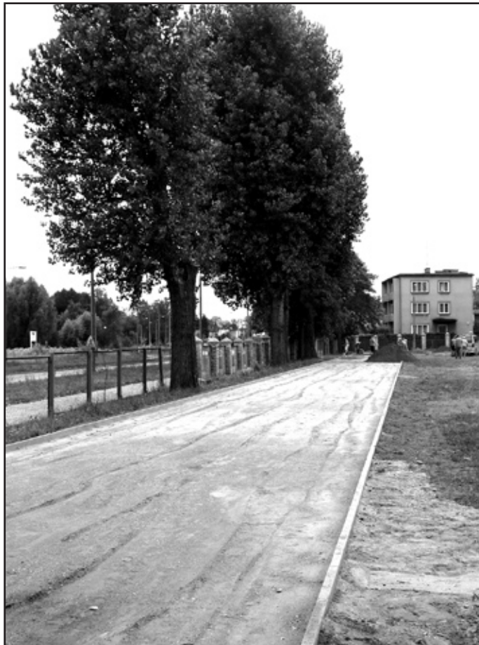
100-metrowa bieżnia przy Gimnazjum Nr 3 w trakcie budowy
