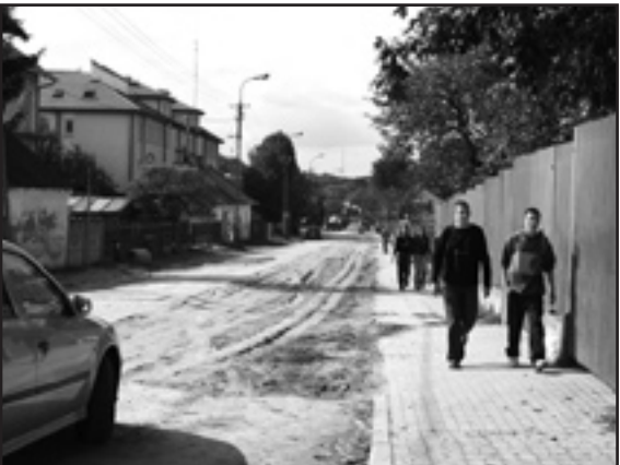
Na tym odcinku ul. Rzeczkowskiej położono już kanalizację deszczową. Niebawem firma drogowa wybuduje tu jezdnię i chodniki
