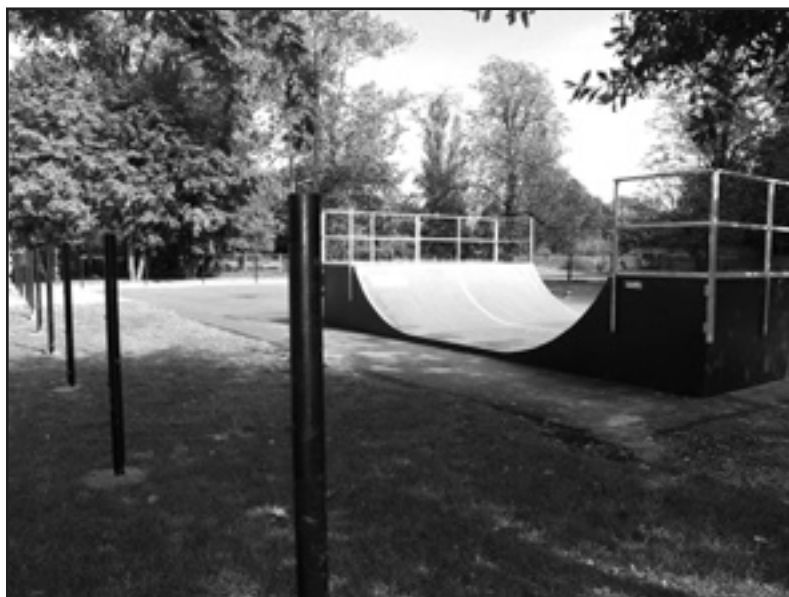
Trwa budowa ogrodzenia skate parku
