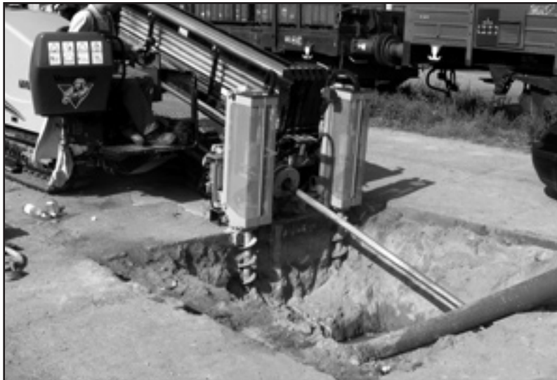
Prace na ul. Towarowej prowadzone są metodą horyzontalnego przewiertu sterowanego
