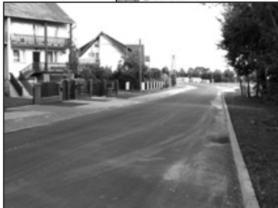
Wykończona ul Różyckiego
