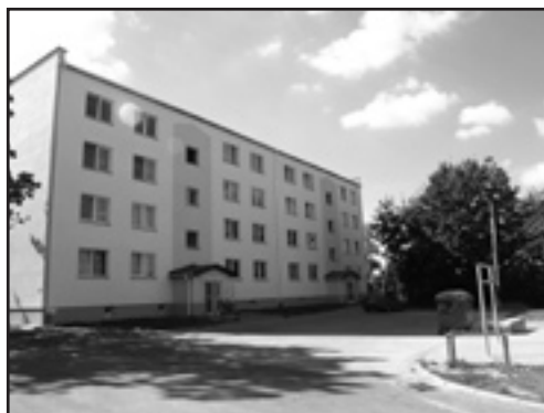
Budynek socjalny przy ul. Komunalnej
