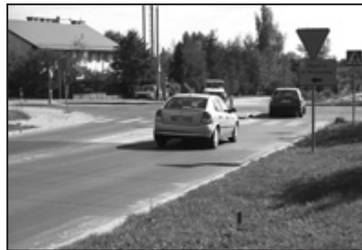
Nakładka na skrzyżowaniu ul. Płockiej i Kolbego
