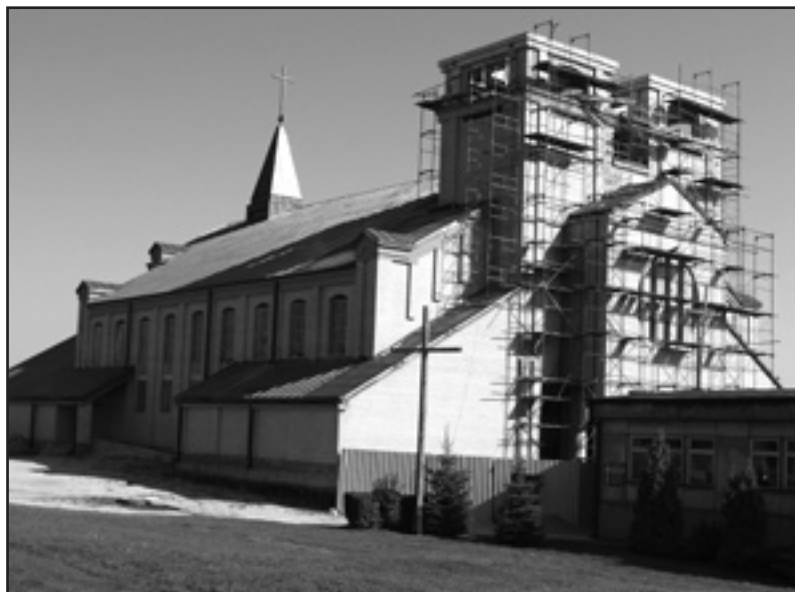
Budowa kościoła Matki Bożej Fatimskiej zostanie niedługo ukończona
