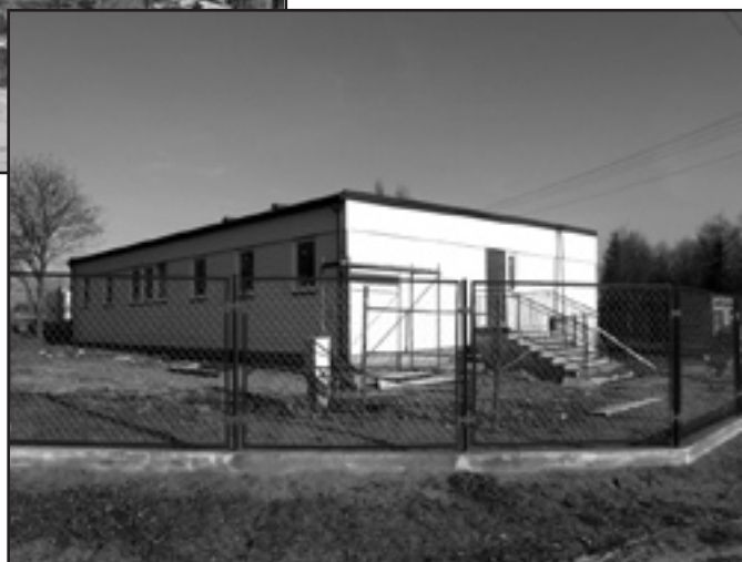
... i pod koniec remontu
