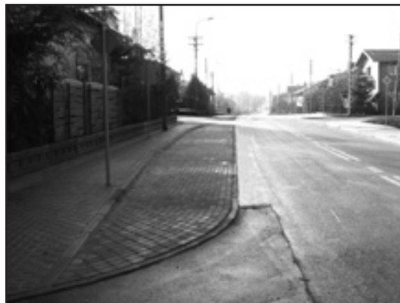
Nowa zatoka autobusowa w ul. Różyckiego
