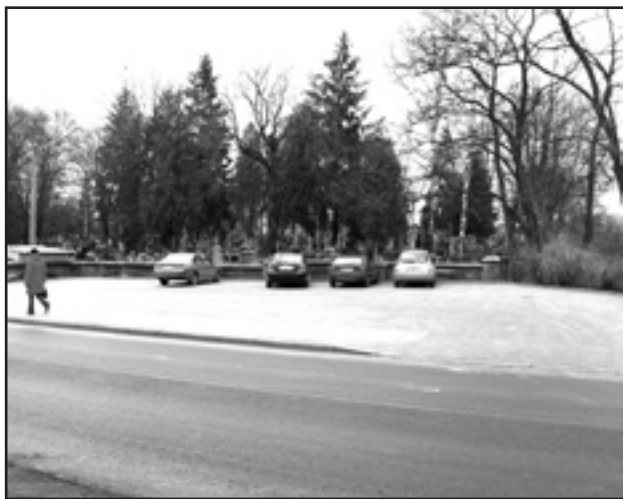
W ramach inwestycji miasto wybudowało parking przy cmentarzu
