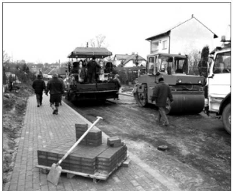
Prace na górnym odcinku ul. Starowiejskiej
