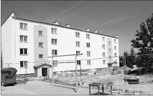
Kolejny blok socjalny na ukończeniu
