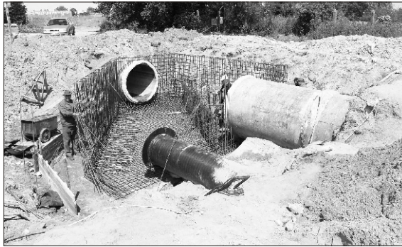
Zbrojenie komory rozdzielczej
