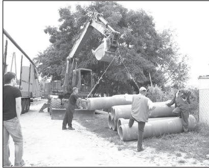
Rozładunek rur do budowy deszczówki w ul. Witosa
