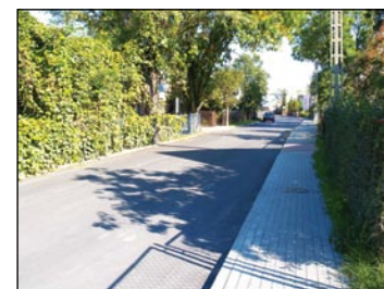
Nowy chodnik i nawierzchnia ul. Zagumiennej
