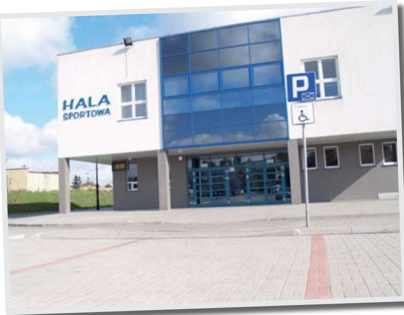
Miejsca parkingowe dla niepełnosprawnych przed nową halą sportową
