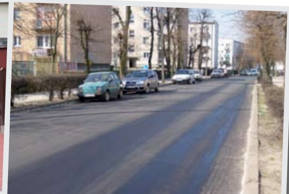
Nowa nawierzchnia na ul. Nadfosnej
