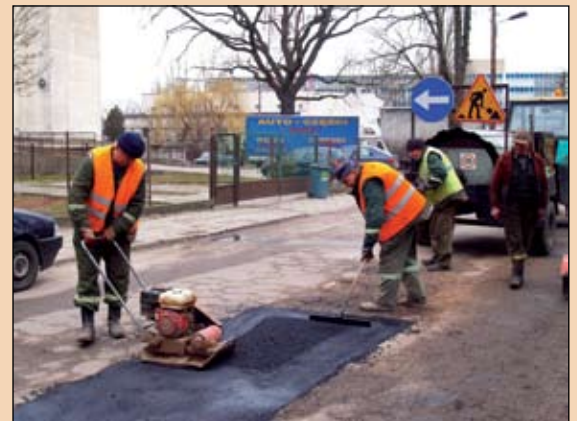
Prace na ul. Małgorzackiej
