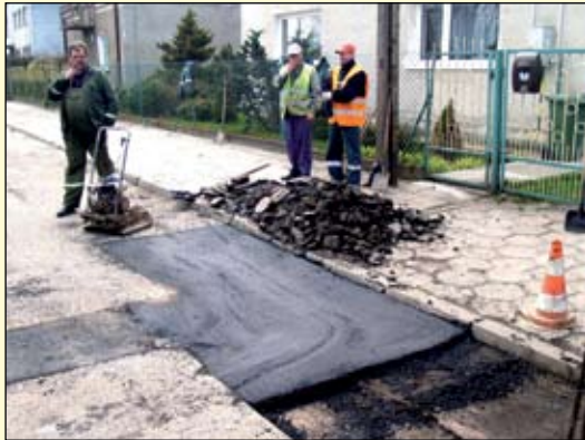
Remont nawierzchni na ul. Jesionowej
