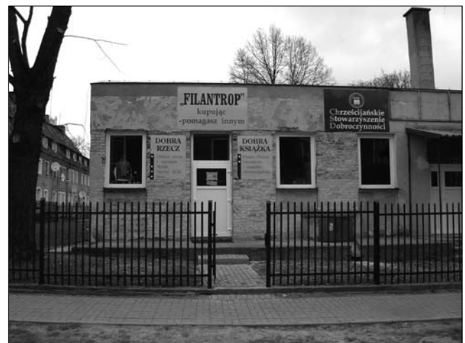
„Filantrop” przy ul. Wyzwolenia 20
