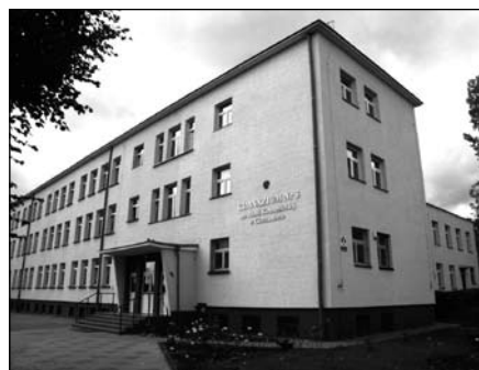
Gimnazjum Nr 3 będzie mieć na parterze nową podłogę z płytek
