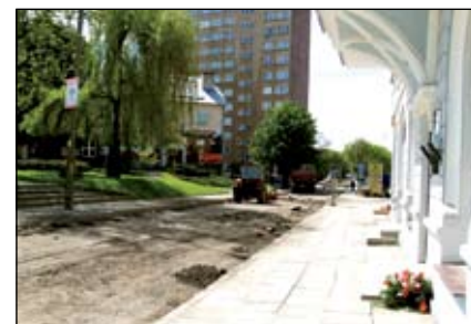
Ul. Ściegiennego w trakcie prac remontowych...
