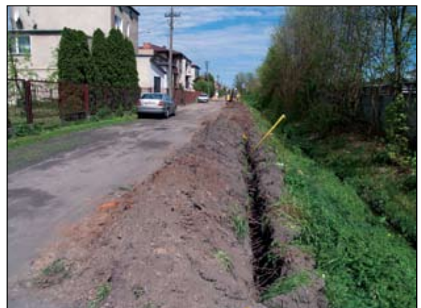
Ulica Parkowa w czasie budowy instalacji gazowej
