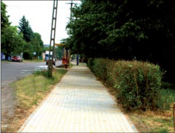
Fragment nowego chodnika wzdłuż ul. Śmiecińskiej
