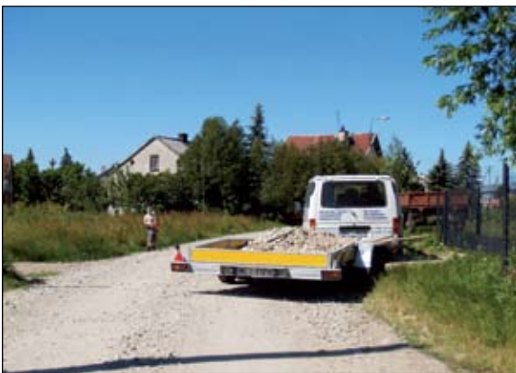
Trwają prace na ul. Wiosennej
