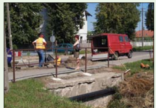
Remont przepustu na ul. Gostkowskiej
