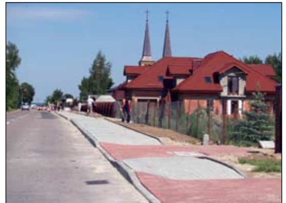
Przy okazji budowy chodnika przy ul. Kolbego wykonano także wjazdy na posesje
