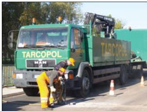
Trwają prace przy dylatacji mostu
