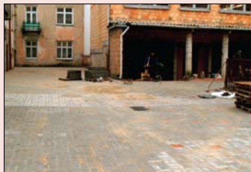
W budowie plac na tyłach ul. Warszawskiej 10a
