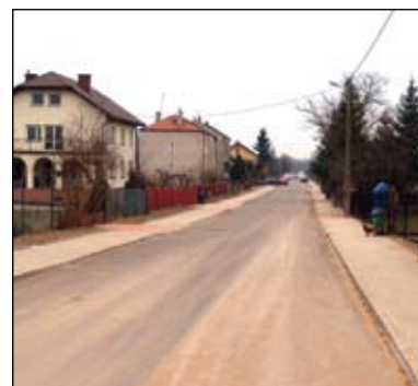
Na Ogrodowej jest już kanalizacja deszczowa, nowa nawierzchnia jezdni i chodniki
