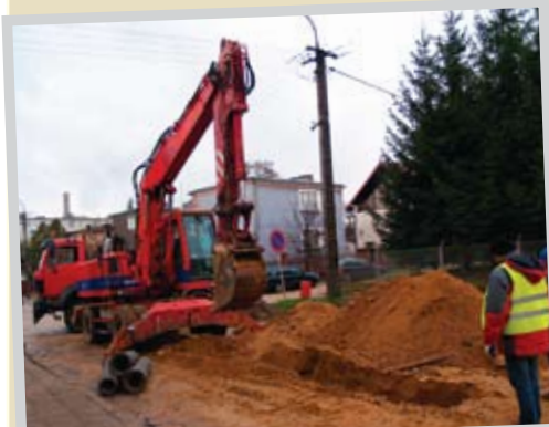
Ul. 11 Listopada podczas układania kanalizacji deszczowej
