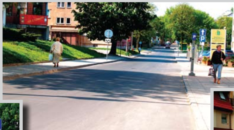
Wyremontowana nakładka na Ściegiennego
