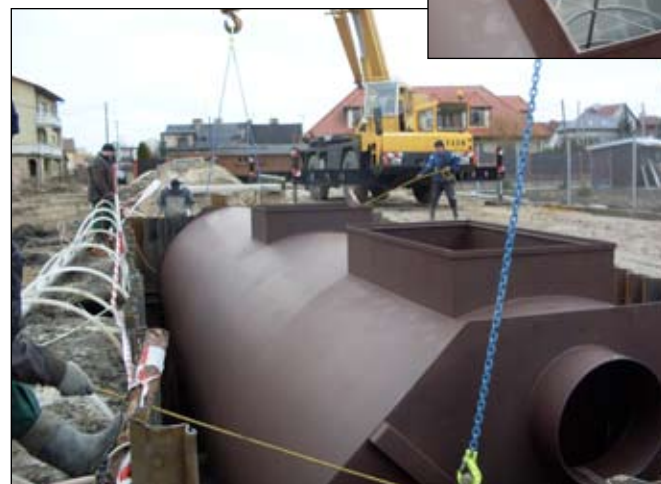
Separator to ogromne i drogie urządzenie, które za chwilę zniknie pod ziemią
