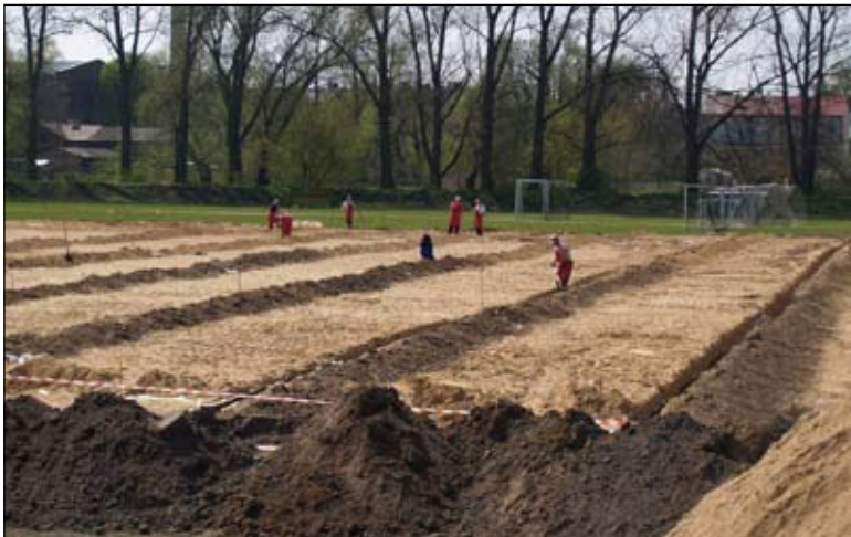
Przygotowanie podłoża pod sztuczną płytę boiska
