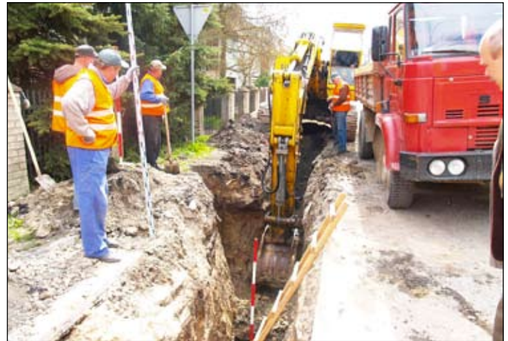
Wykopy pod kanalizację deszczową w ul. Lawendowej
