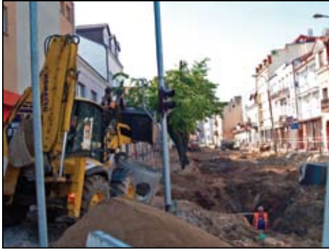
Roboty na Warszawskiej idą pełną parą
