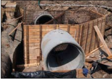
Stalowe zbrojenie komory separatora
