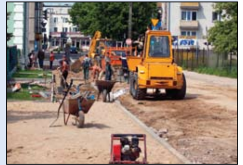
Powstaje nowy chodnik na ul. 11 Listopada
