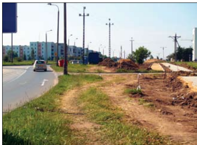
Ruszyły prace budowlane na ul. Armii Krajowej
