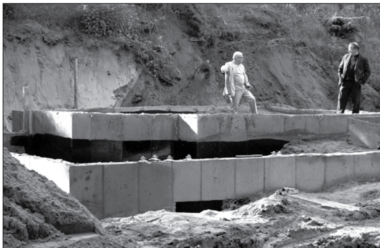
Prace obserwują autor projektu M. Zalewski i ordonnik inicjatywy ks. D. Skoczylas
