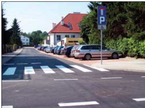
Na ul. Nowozagumiennej, oprócz sieci deszczowej, nawierzchni i chodników powstały nowe miejsca parkingowe
