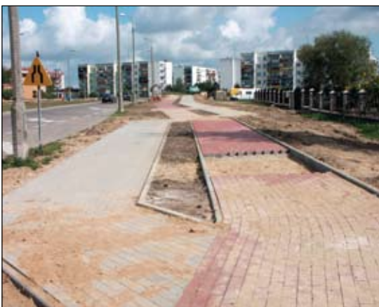
Powstają kolejne chodniki. Widok od strony ul. Płońskiej
