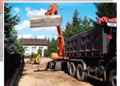
Prace na dolnym odcinku drogi
