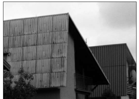
Miasto dofinansowuje demontaż azbestowych dachów
