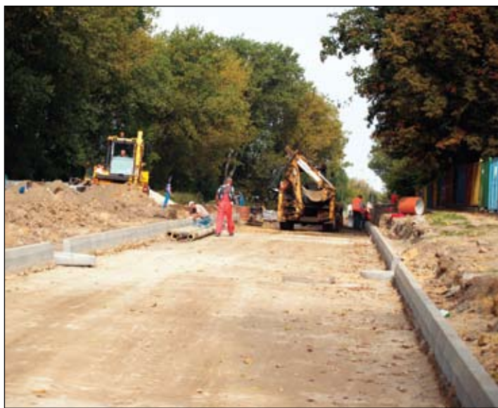
Prace na ulicy budowanej wzdłuż Łydni postępują bardzo szybko
