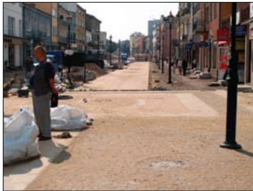
Od początku października posadzkę na ul. warszawskiej układać będą dwie ekipy
