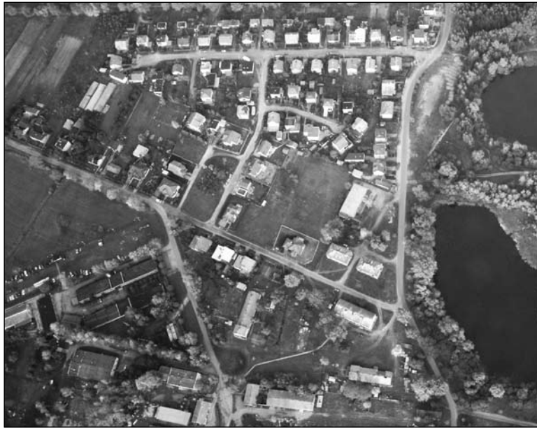
Jedną z planowanych dużych inwestycji jest budowa kanalizacji sanitarnej na osiedlu Krubin
