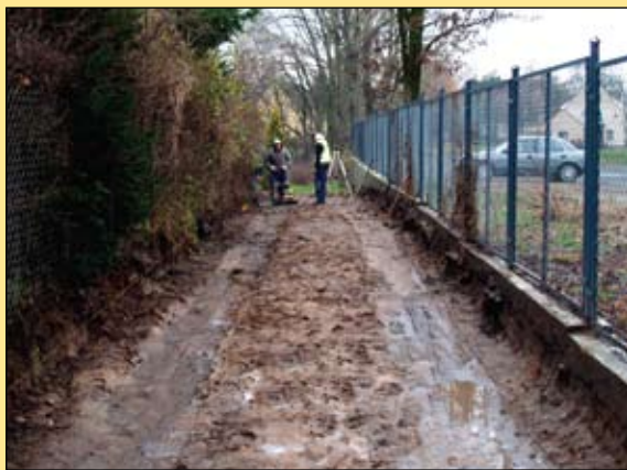
Zakończyły się prace ziemne – wybudowano kanalizację deszczową, czas na utwardzenie podłoża pod nawierzchnię ulicy
