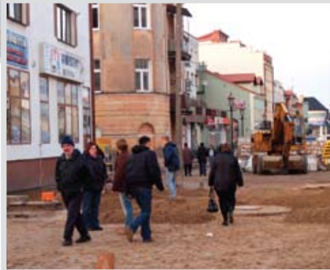
Prace w obrębie skrzyżowania z ul. Sierakowskiego prowadzone są tak, by nie blokować ruchu pieszych
