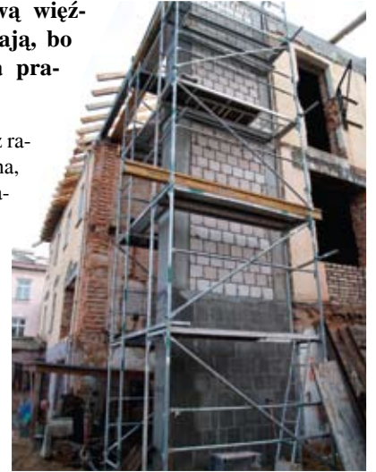
Powstaje sztyb windy dla osób niepełnosprawnych
