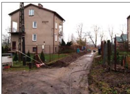
Budowa oświetlenia w ul. Wiejskiej
