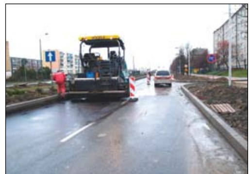
Wymiana asfaltu na prawym pasie ul. Armii Krajowej od strony Pułtuskiej
