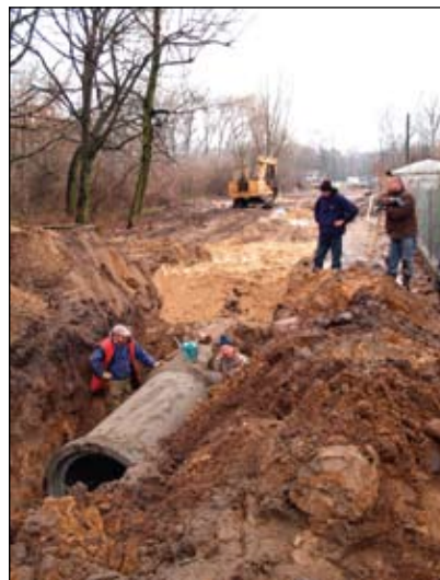
Budowa kolektora deszczowego
