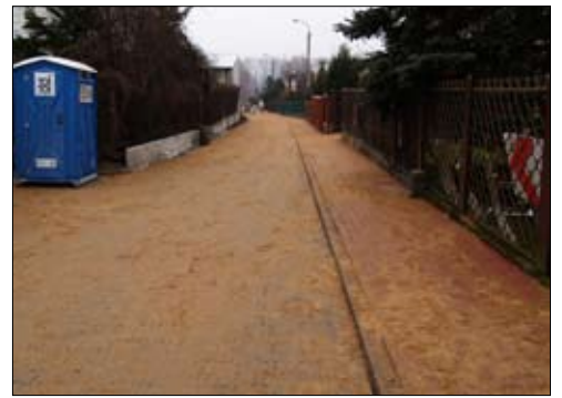
Nowa nawierzchnia ul. Olchowej
