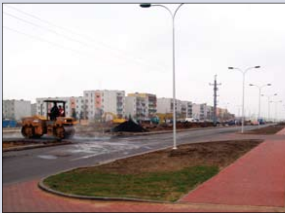
Wzdłuż drogi uruchomiono już oświetlenie uliczne
