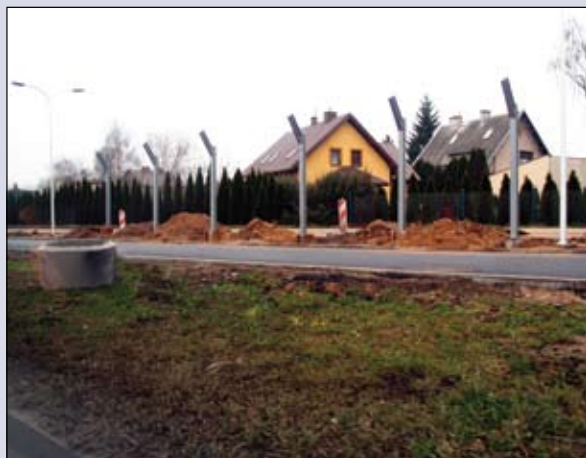
Słupy konstrukcyjne pod ekrany dźwiękochłonne
