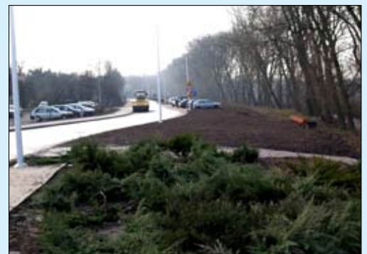
Nowa droga wzdłuż Łydyny
