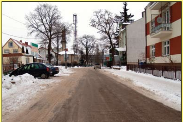
Ul. Małgorzacka będzie przebudowana w tym roku
