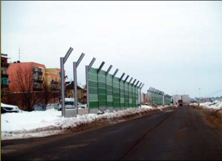
Część dźwiękochłonnych ekranów została już zamontowana wzdłuż ul. Armii Krajowej
