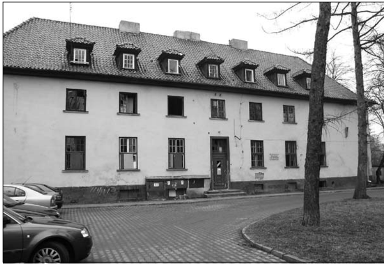
Budynek przy ul. Sienkiewicza nie zostanie wystawiony do przetargu
