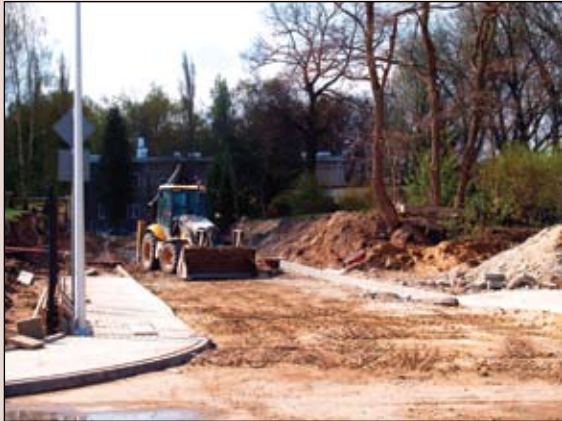
Budowa nowej drogi w kierunku ul. Strażackiej
