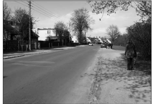
Dzięki współpracy miasta i powiatu mieszkańcy będą mieli tu nowe chodniki i wyremontowaną jezdnię
