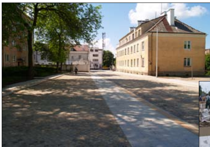
Nadfosna jest już gotowa, na Mikołajczyka trwają prace
