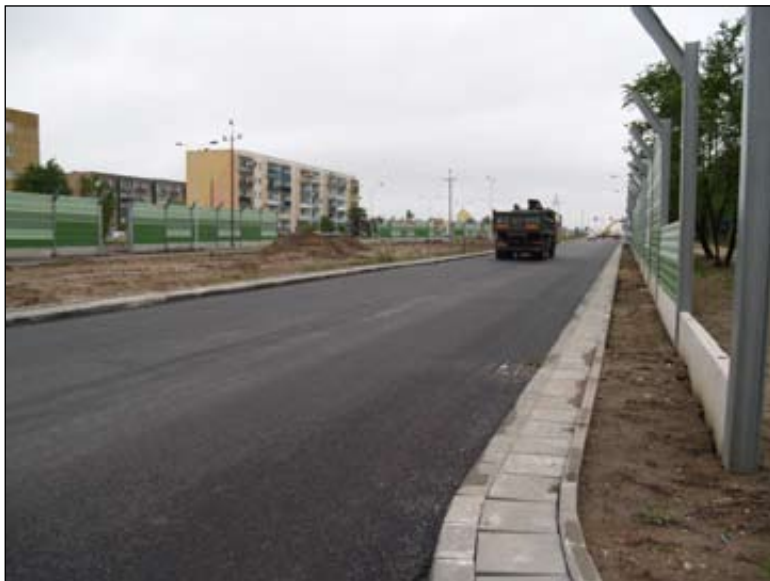
Na ul. Armii Krajowej położono wierzchnią warstwę asfaltu
