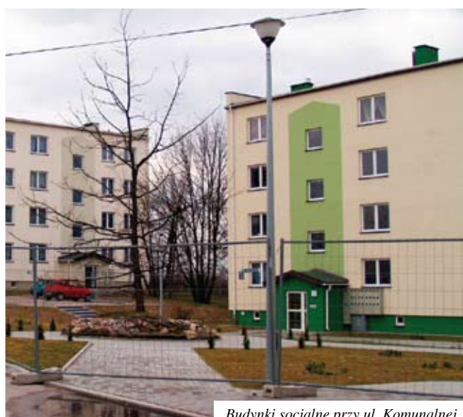
Budynki socjalne przy ul. Komunalnej
