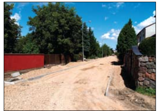
Ul. Bohaterów Westerplatte w trakcie budowy
