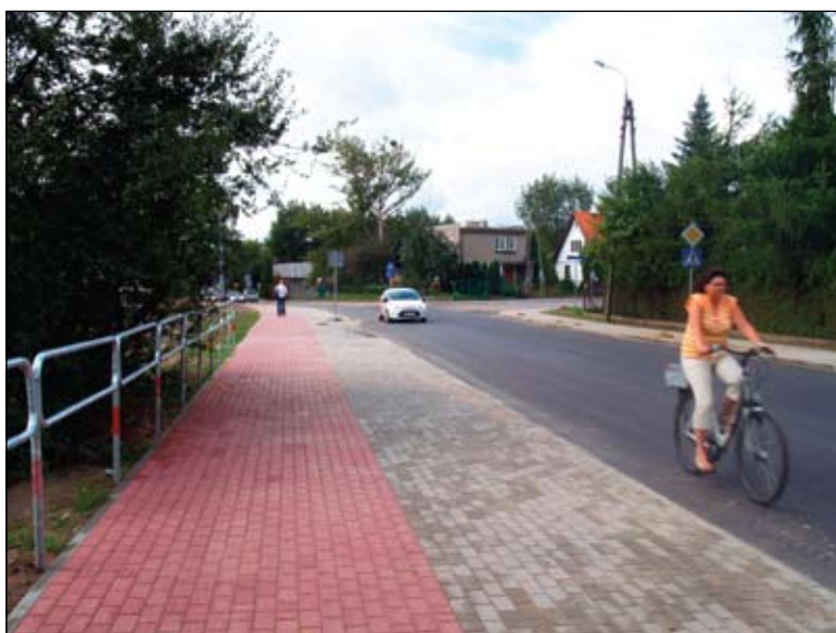
Ul. Kraszewskiego. Nowy chodnik z miejscami parkingowymi i ścieżką rowerową
