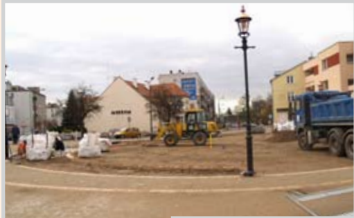
Zegar słoneczny w trakcie budowy
