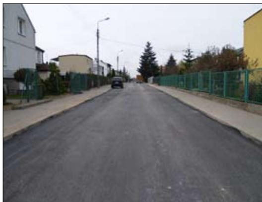
Nowa nawierzchnia na ul. Kicińskiego
