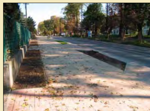
W ulicy Wojska Polskiego ZWiK zbudował sieć kanalizacji sanitarnej
