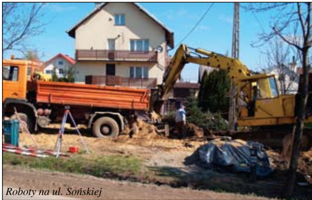
Roboty na ul. Sońskiej
