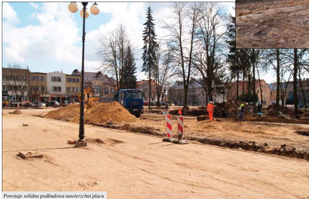
Powstaje solidna podbudowa nawierzchni placu
