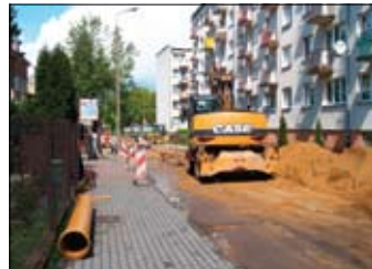
Budowa kanalizacji deszczowej w ul. Kilińskiego
