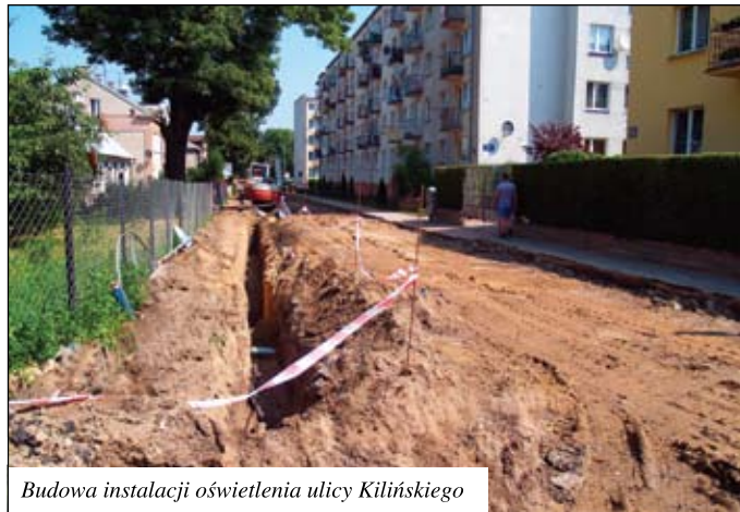
Budowa instalacji oświetlenia ulicy Kilińskiego
