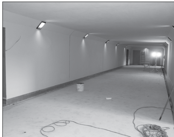
Podziemne przejście między peronami dworca PKP jest gotowe, trzeba tylko posprzątać
