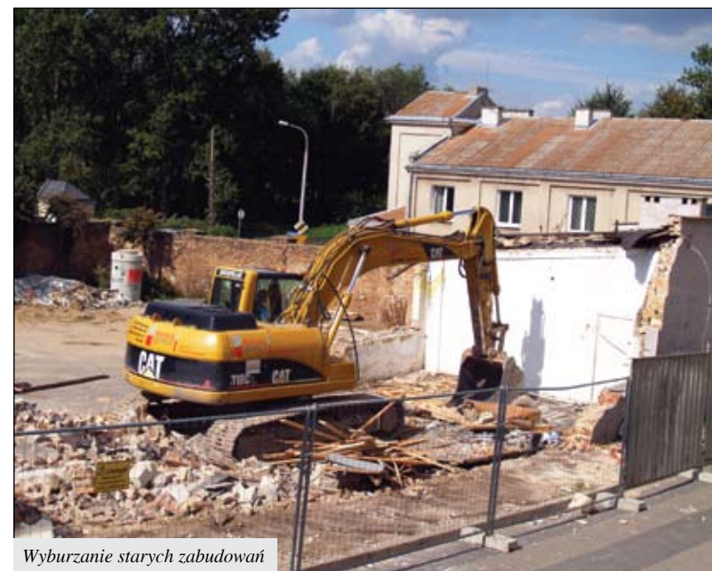
Wyburzanie starych zabudowań
