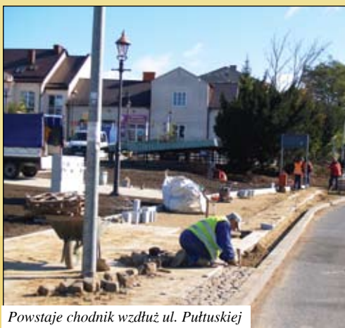
Powstaje chodnik wzdłuż ul. Pułtuskiej
