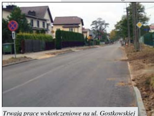
Trwają prace wykończeniowe na ul. Gostkowskiej
