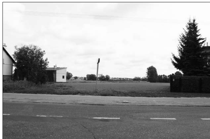
To teren przyszłego ronda. Od ul. Sienkiewicza pętla będzie tędy prowadziła na Kargoszyń
