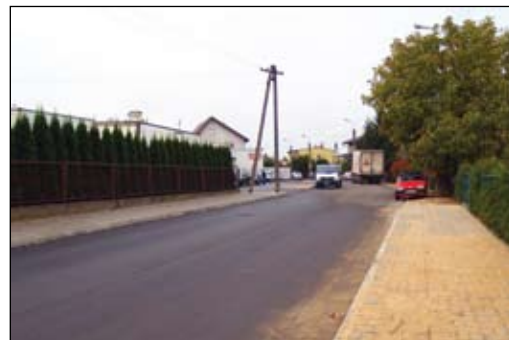
Ul. Broniewskiego. Piasek musi wypełnić szczeliny w nowym chodniku
