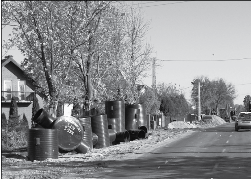
Te potężne rury są już wkopane w ul. Wojska Polskiego
