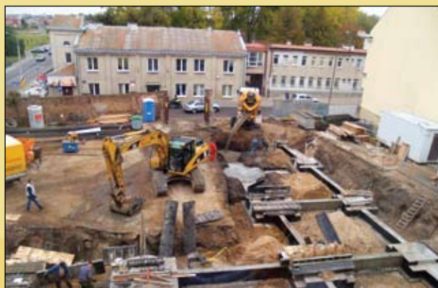
Fundamenty, na których stanie nowoczesny biurowiec na tyłach ratusza
