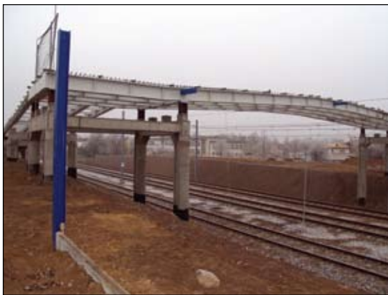
Kładka łącząca ul. Nowokolejową i Widną w budowie
