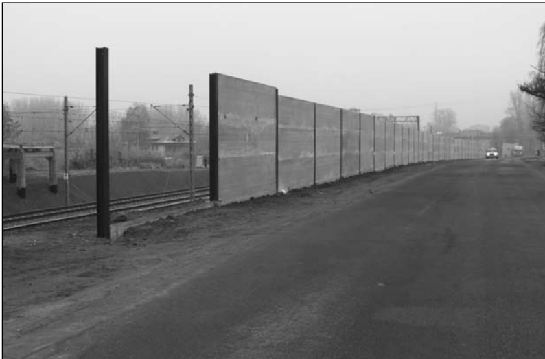
Betonowe konstrukcje postawione przez PKP wzdłuż ul. Przytorowej
